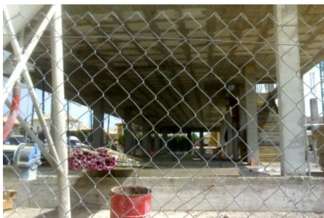
Obras del Centro de Salud Olivar de Quinto
